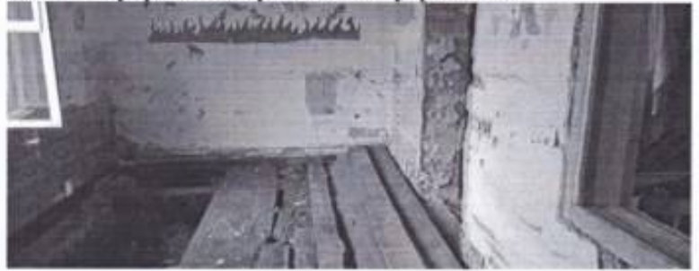
Корпус №1 /старший/вид внутри здания
