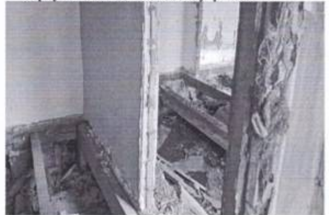
Корпус №2 /младший/ вид внутри здания
