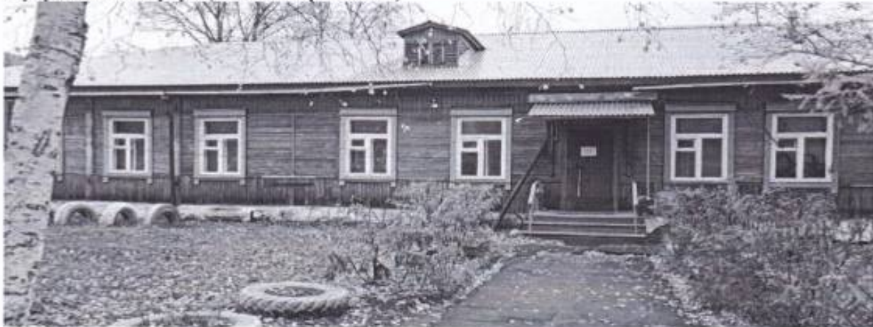
Корпус №3 /хоз.корпус/ (не демонтированный)
